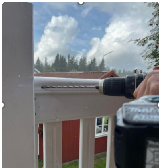
Skråskruva och förborra överliggaren Mot stolpen.
