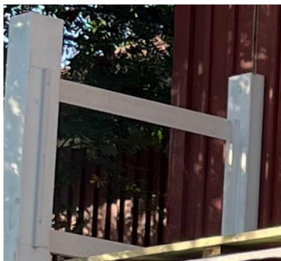
Övre och undre spjällhållare monterade.
